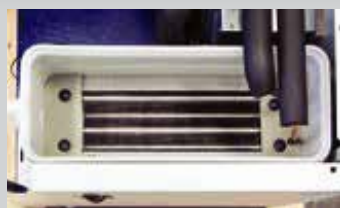
Inovativni rebrasti isparivač visoke efikasnosti.
